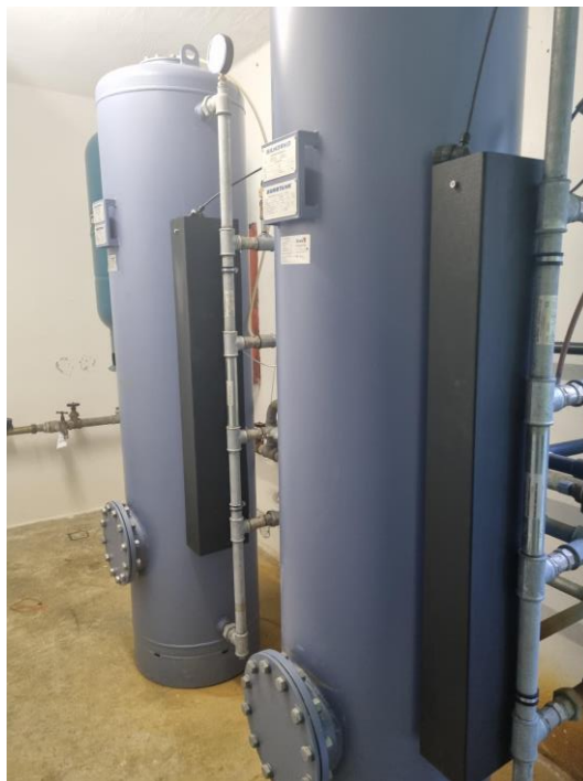
For- og efterfilter.
