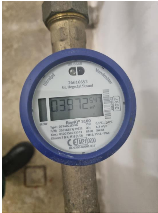
Vandmåler, afgang vandværk.
