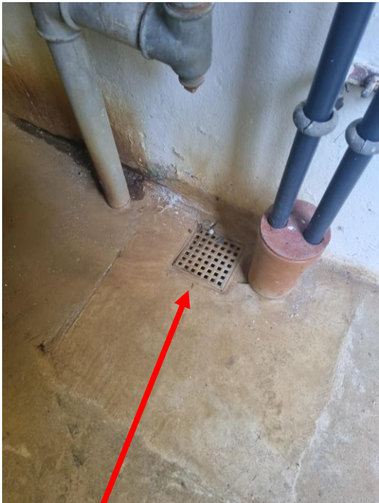
Afløbsforhold i vandværksbygning.
