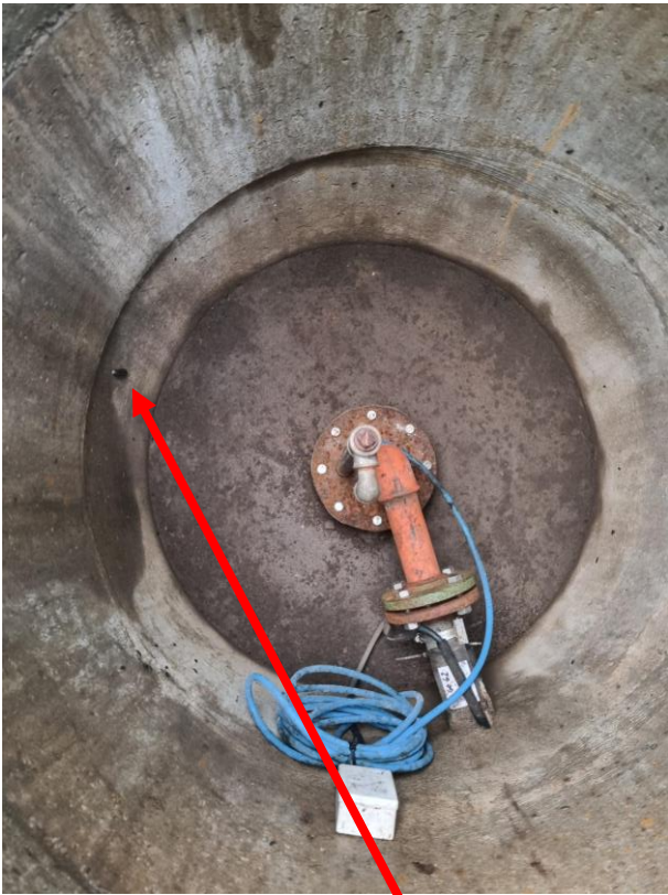
Vandforsyningsboring - skovsnegl er fjernet efter tilsyn.
